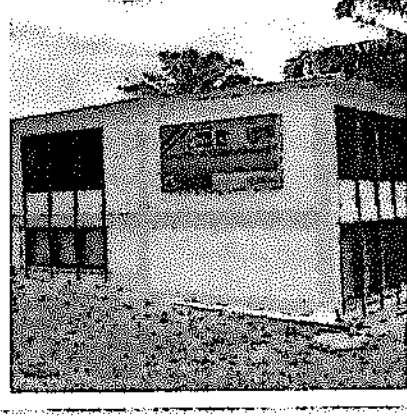
Figura 12. Inspección en la Estación de Gigante
