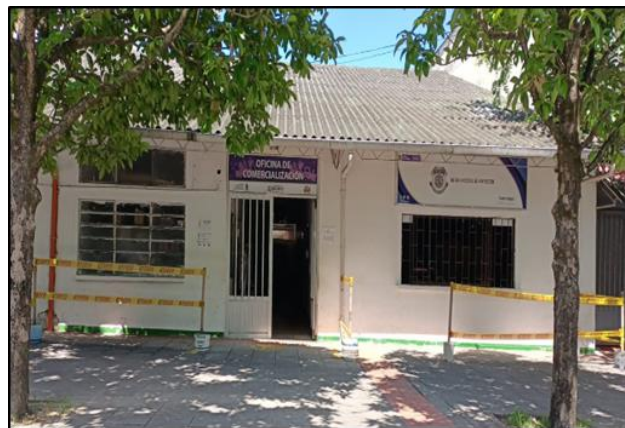
Fotografía 6. Oficina Yopal – Casanare
