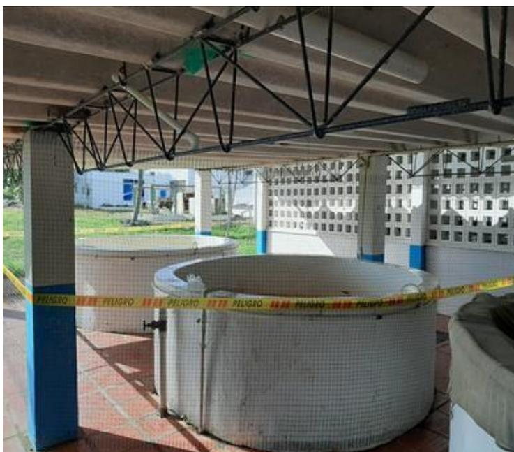
Foto 22 Tanques circulares unidad de tratamiento y disposición de vertimientos – Estación Piscícola del Bajo Magdalena - Repelón (Atlántico)
