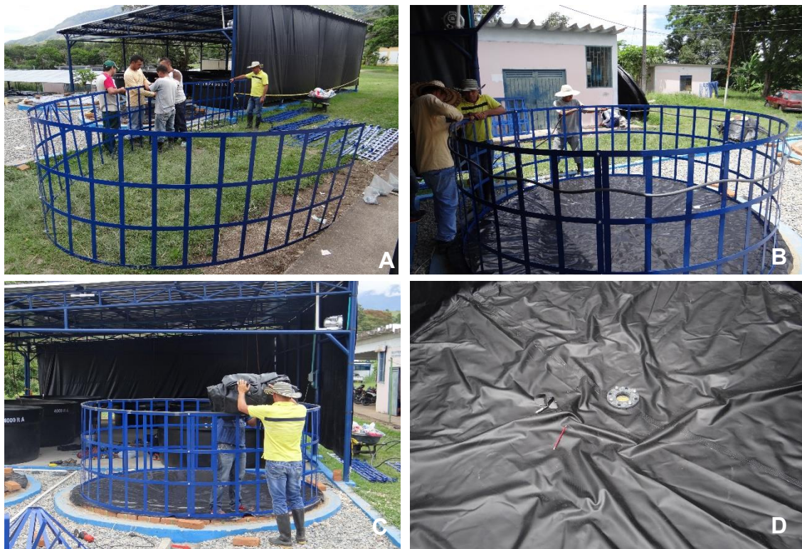
Figura 2. Construcción del sistema acuaponico.
