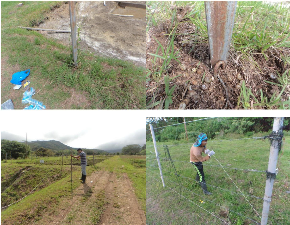
Imagen 4. Adecuación postes, instalación, templado de alambre y tendido de malla
