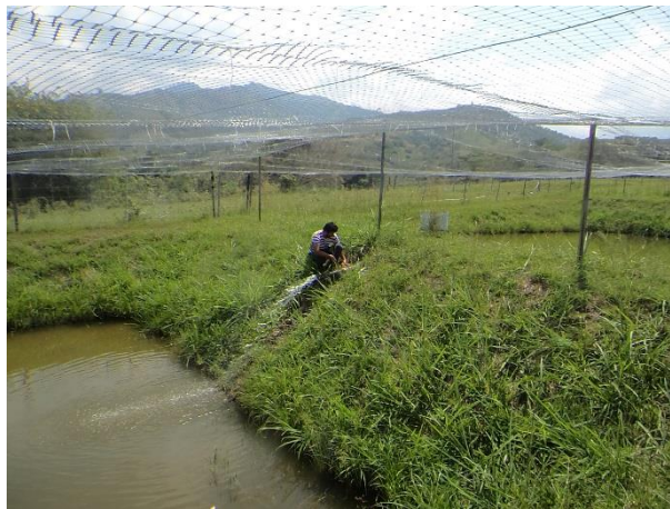
Imagen 15. Llenado de estanque hasta nivel franco de seguridad.
