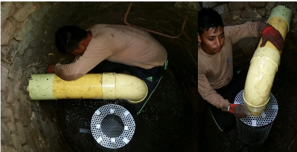
Imagen 12. Instalación de trampa de retención.
