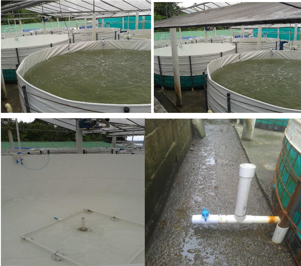
Figura 4. Tanques en geomembrana utilizados en la siembra de pargos lunarejos, Lutjanus guttatus ., estructura externa y interna en Bahía Málaga. Fuente: Arias, 2015.
