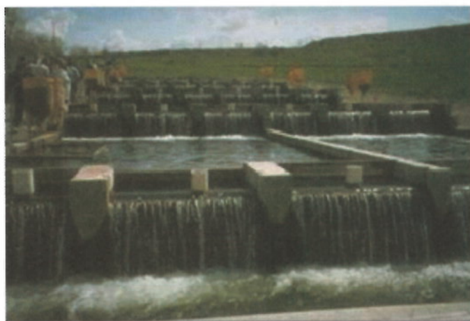
Figura 55. Estanques en cemento para cultivo de trucha.
