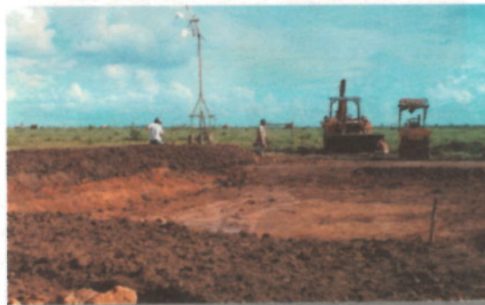
Figura 11. Conformación de las paredes de los estanques.
