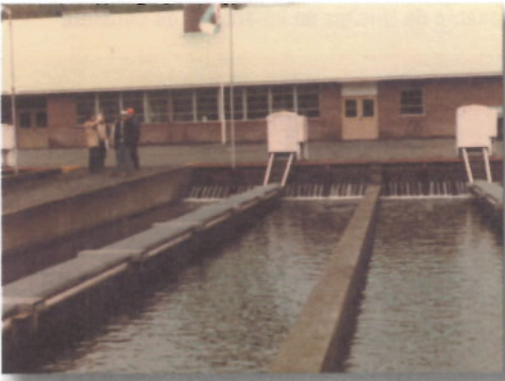
Figura 28. Estanques en cemento.
