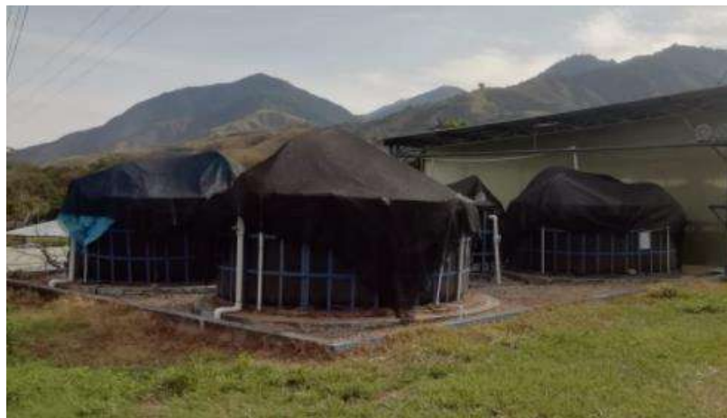
Foto 13. Área de las geomembranas en la Estación Piscícola del Alto Magdalena (EPAM) – Gigante (Huila).
