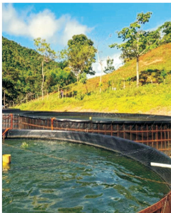
Foto 9. Finca Piscícola. Infraestructura Estanques en Geomembrana. Municipio de Mahates, Bolívar. Foto tomada por agente Ismael Yepes, 2022.
